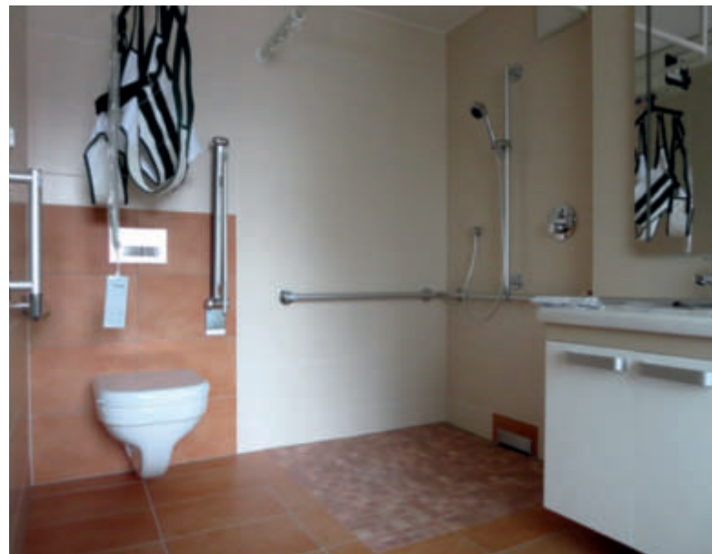
Vom 70er-Jahre-Bad mit 20-Zentimeter-Stufe beim Duscheingang (oben) zum barrierefreien Bad (rechts).
