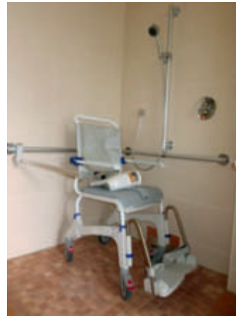
Die Dusche ist auch dank der Anordnung der Bedienelemente ebenso auf die Benutzung mit Rollstuhl ausgelegt wie der unterfahrbare Waschtisch.
